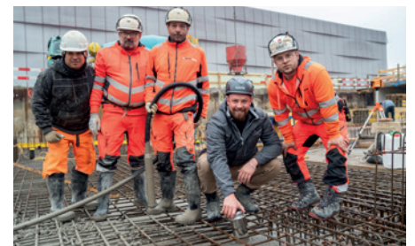
Ein Moment für die Geschichte: die Zeitkapsel wird einbetoniert.
