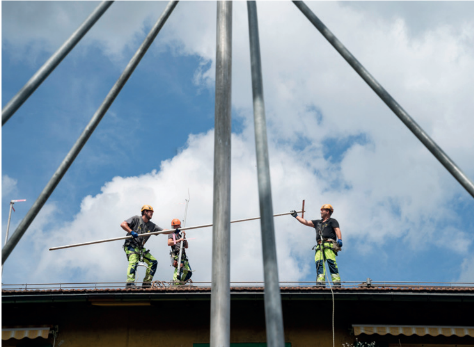
Errichtung der Bauvisiere in der Siedlung Affoltern.
